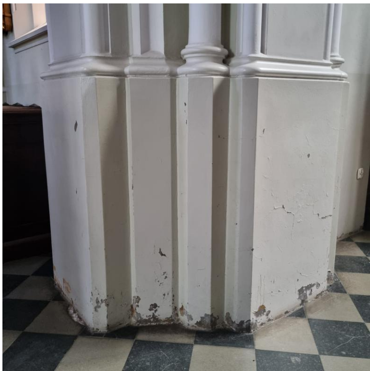
FOT. 11. Komarówka Podlaska, kościół, przykładowe uszkodzenia w partii lamperii, 2024.
