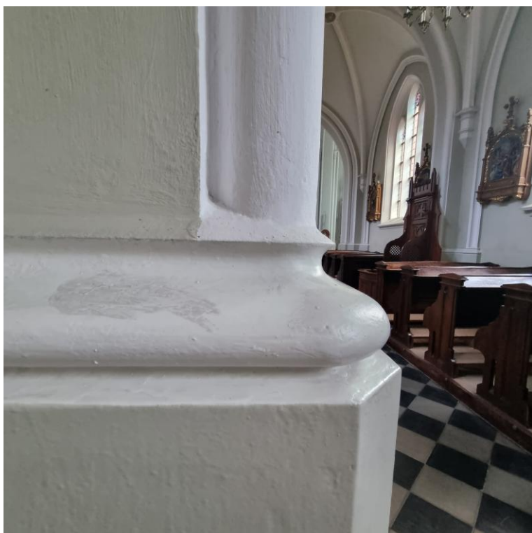
FOT. 10. Komarówka Podlaska, kościół, przykładowe uszkodzenia w partii gzymsu nad lamperią (nieliczne), 2024.
