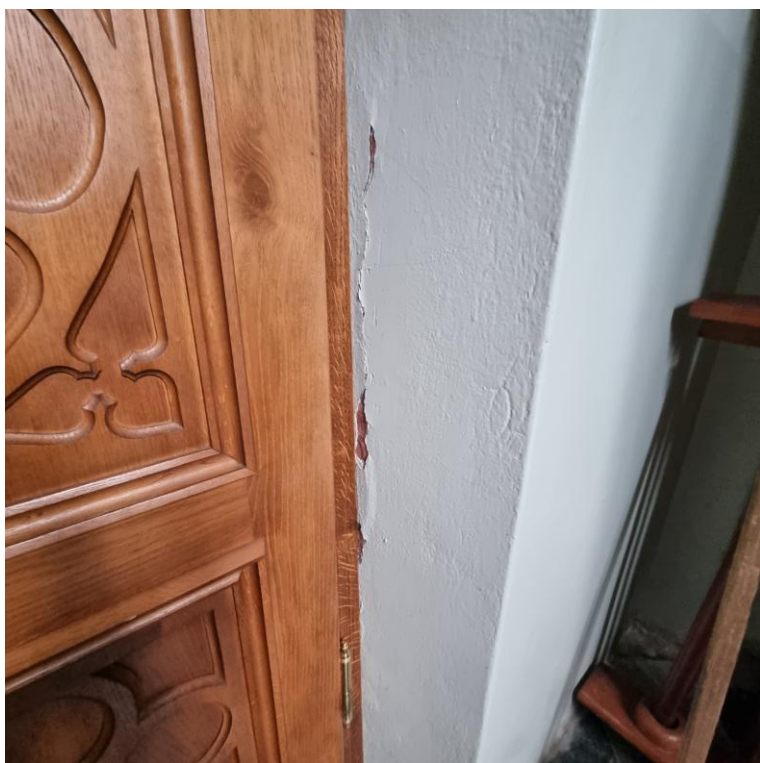
FOT. 13. Komarówka Podlaska, kościół, kruchta lewa, ubytki w gładzi drzwiowych, 2024.
