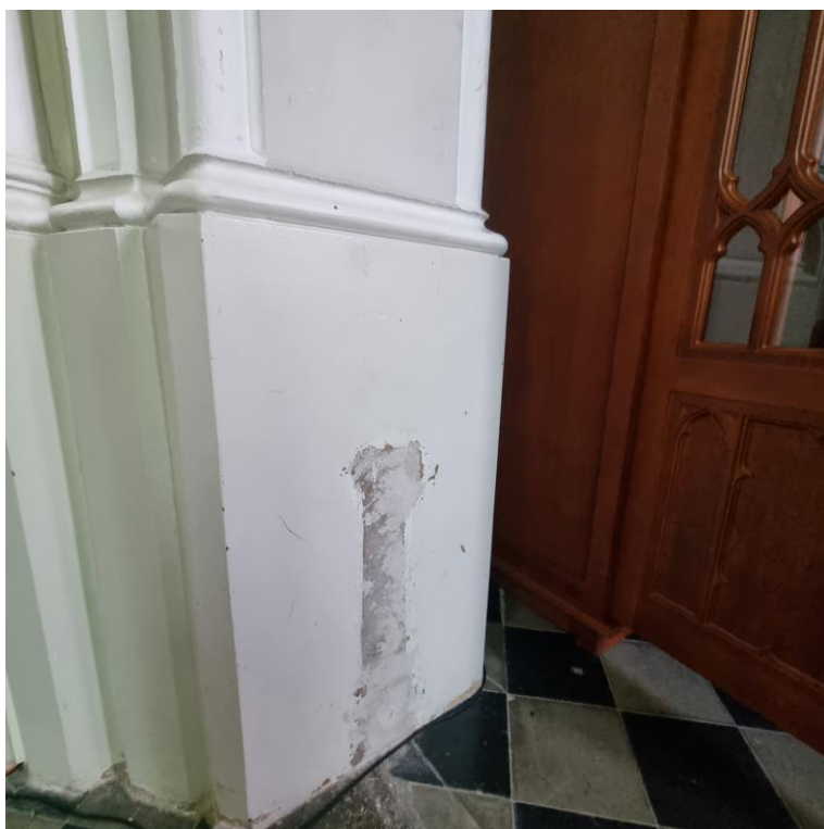
FOT. 15. Komarówka Podlaska, kościół, ubytki tynku po zdemontowaniu balustrady w kaplicy prawej (podobne uszkodzenia również po stronie prawej), 2024.
