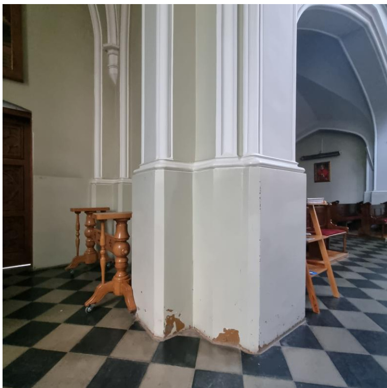
FOT. 8. Komarówka Podlaska, kościół, przykładowe uszkodzenia w partii lamperii, 2024.
