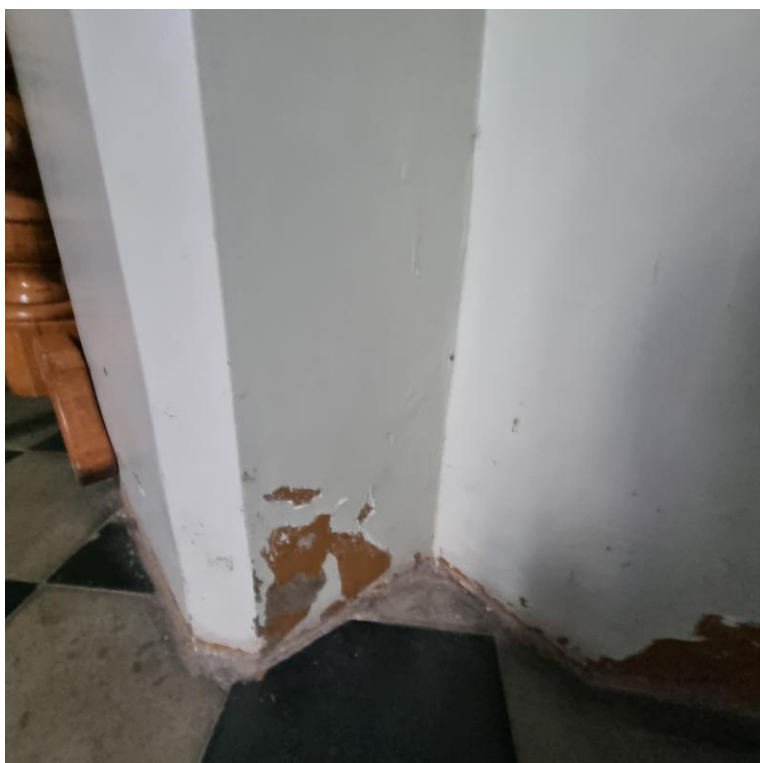
FOT. 9. Komarówka Podlaska, kościół, przykładowe uszkodzenia w partii lamperii, 2024.
