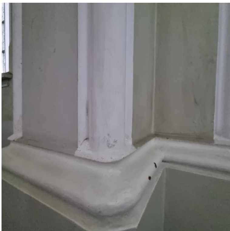
FOT. 16. Komarówka Podlaska, kościół, ubytki na ścianach w kaplicy prawej, 2024.
